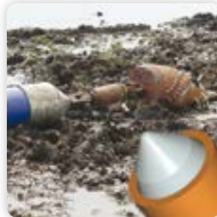
7 - Horizontales Bohren HDD
